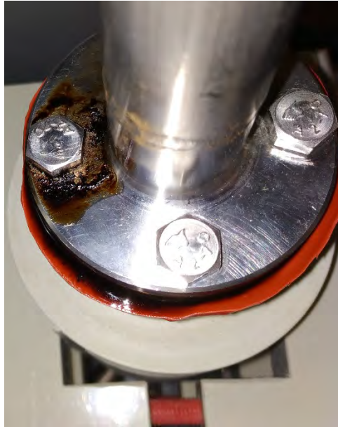
Abbildung 8: aufgrund einer kleinen Leckage ausgetretene und angetrocknete Bierwürze an Verschraubung des Reaktors.
