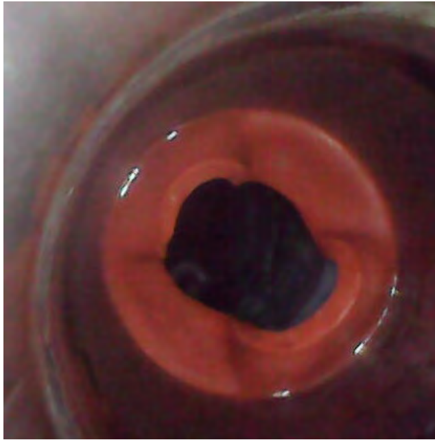
Abbildung 2: Dichtung bei Übergang Rohrleitung zu Reaktor, deutlich in den Raum ragend.
