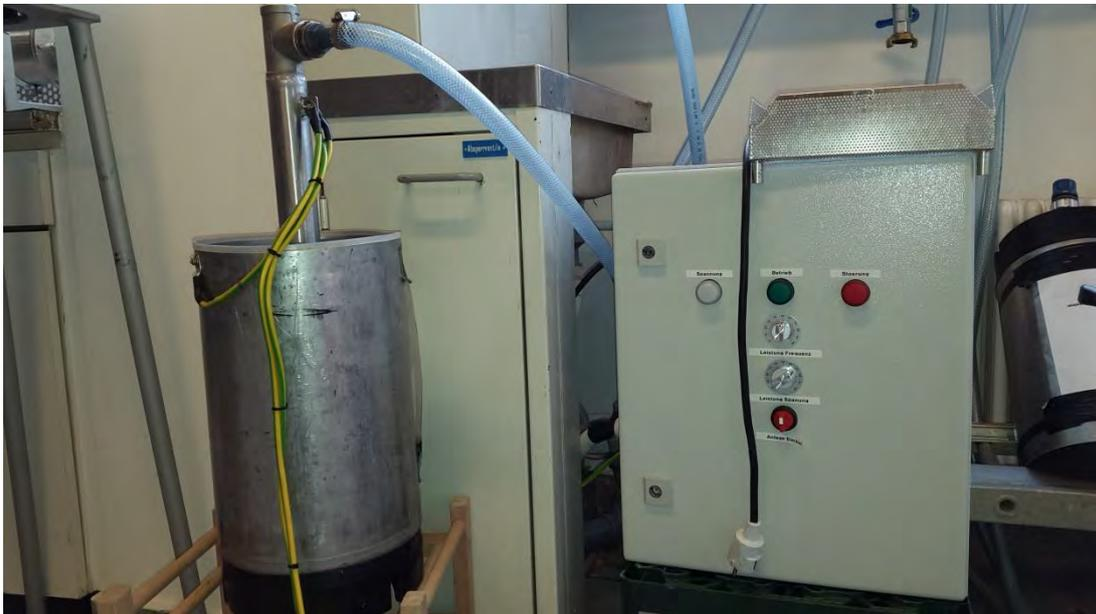
Abbildung 26 Ionisationsmodul für Nassweiche System 2
